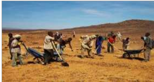
Réhabilitation des pistes rurales de la commune de Tabelot.
